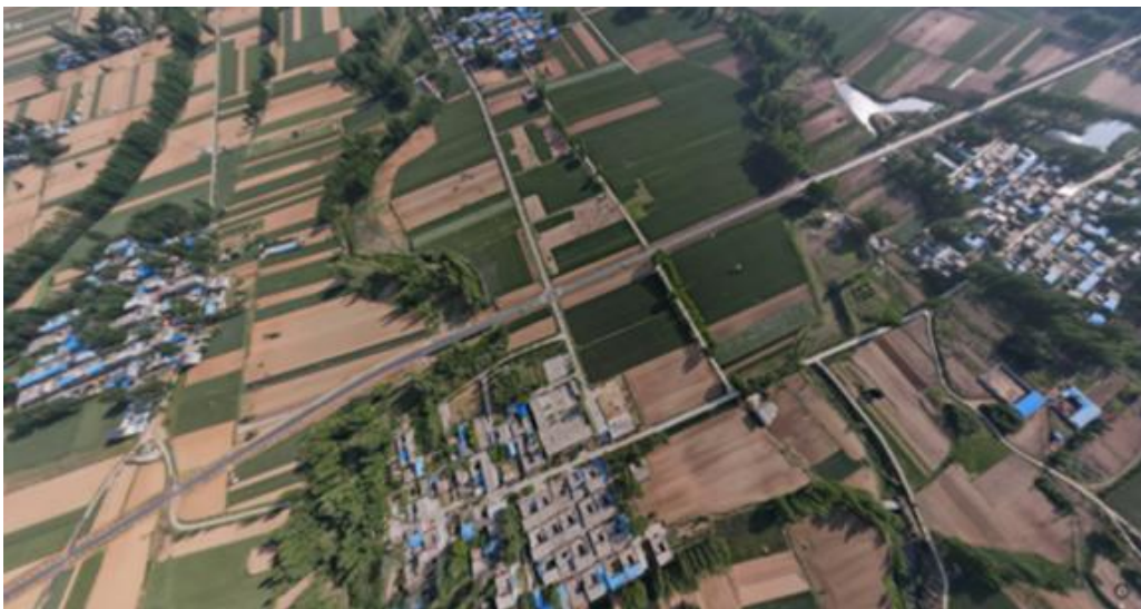
图 3-11 河坡村三维实景地图
